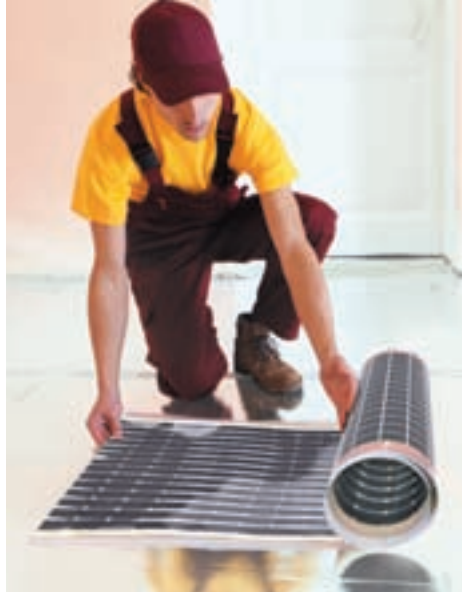
Рис. 6. Раскатывание рулона теплого пола CALEO PLATINUM на теплоотражающем материале
