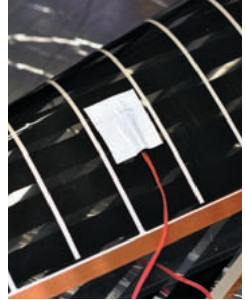
Рис. 24. Установленный и приклеенный датчик температуры пола. Вид снизу термоленки
