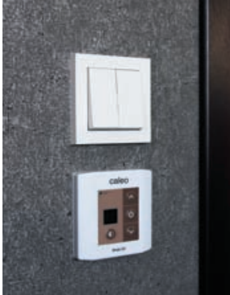
Рис. 26. Терморегулятор, подключенный к сети
