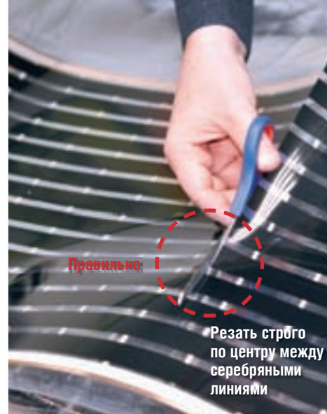
Рис. 7. Разрезание термопленки CALEO PLATINUM посередине между серебрянными линиями, расположенными перпендикулярно медной шине
