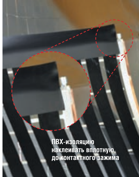
Рис. 11. Наклейка ПВХ изоляции на срез пленки
