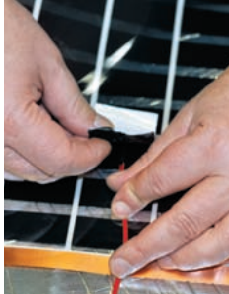
Рис. 23. Датчик прикрепляется к термоленке битумной изоляцией
