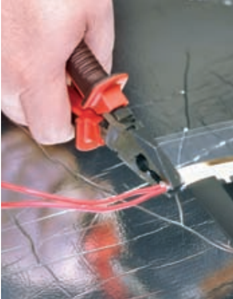
Рис. 16. Надежно зажмите провода в контактном зажиме
