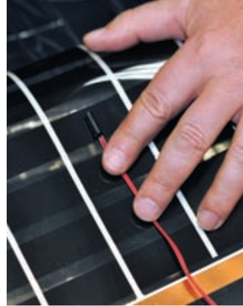
Рис. 21. Установка датчика температуры пола SF 4x15
