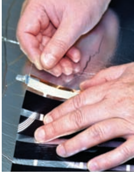
Рис. 8. Установленный на термоленку контактный зажим
